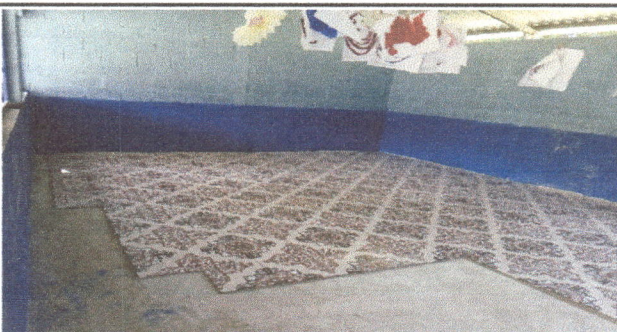
AULA CASI TERMINADA
